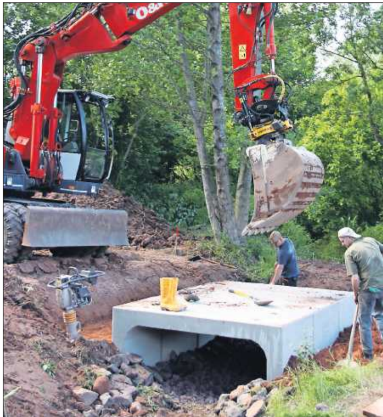
Die Brückenfundamente am Eibach werden eingebaut. FOTO: WERNER WAGNER
